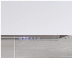
La hotte s'installe à l'intérieur des armoires de cuisine, seulement les commandes sont visibles.
